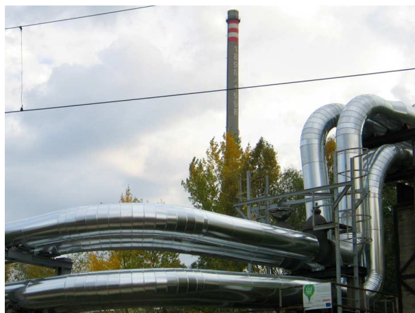
Az erőmű telkén belül találkozik a két felújított vezetékszakasz
