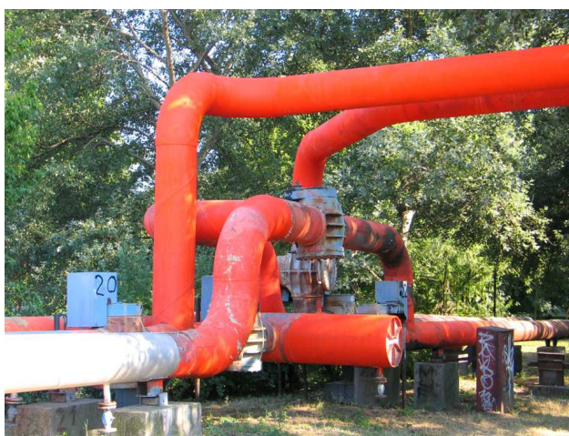
Új szigetelést kapott az elosztópont
