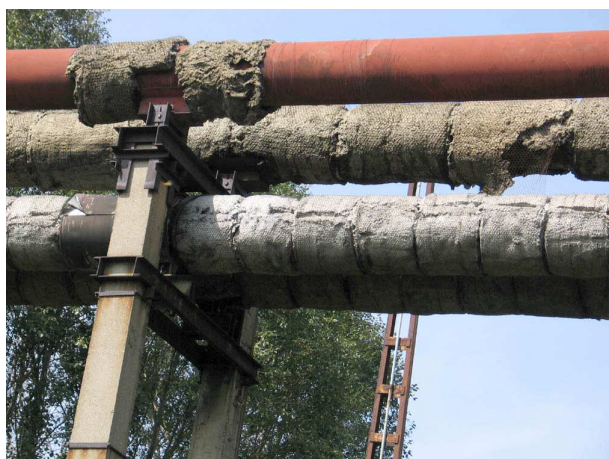
A Hőerőműből induló négyvezetékes rendszer
